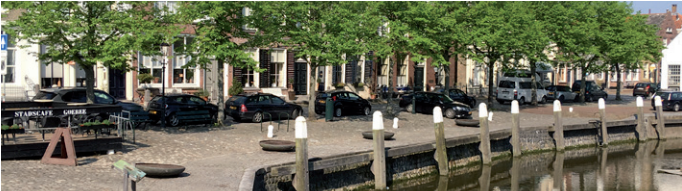
huidige situatie: straat en onaantrekkelijk talud
