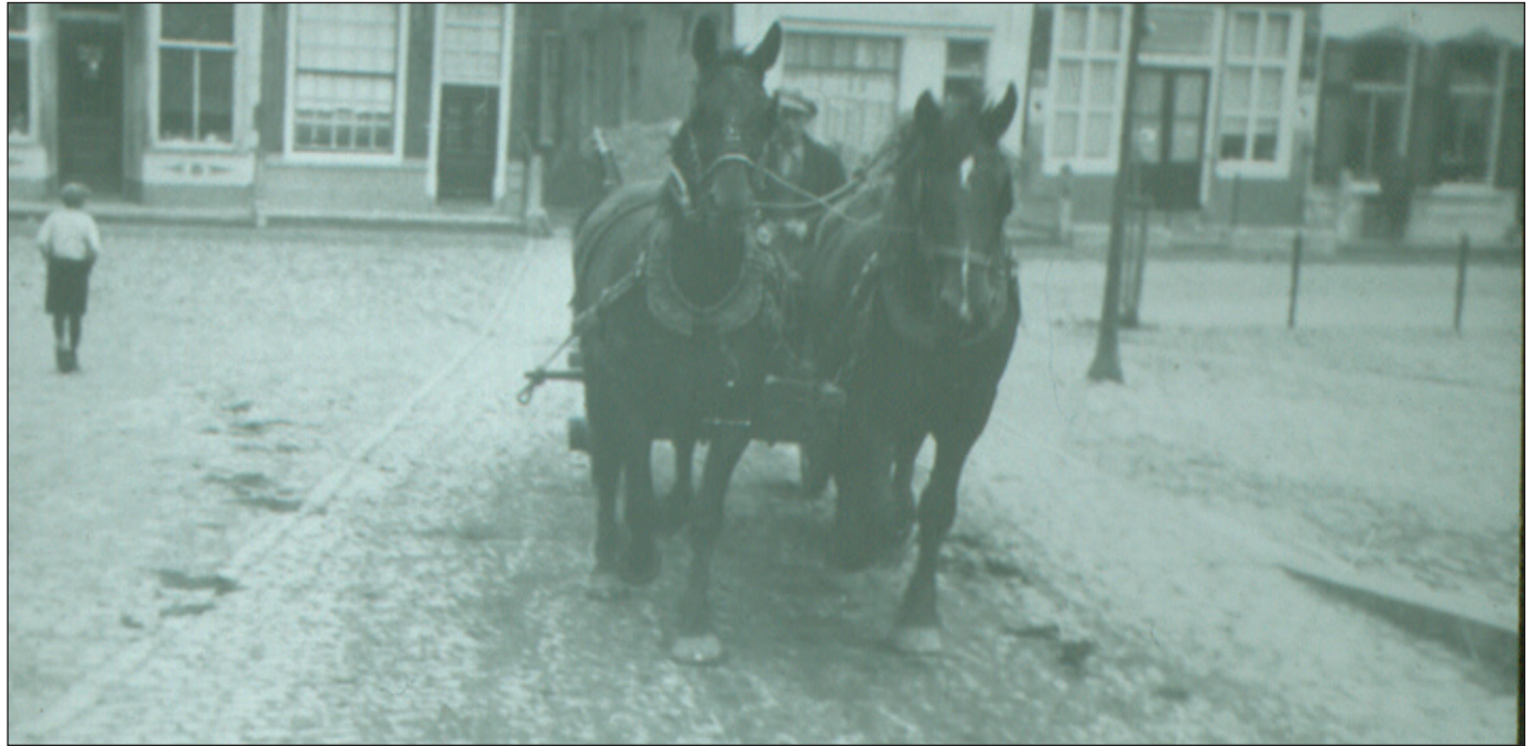
lijn over de markt van brug naar grote slop
