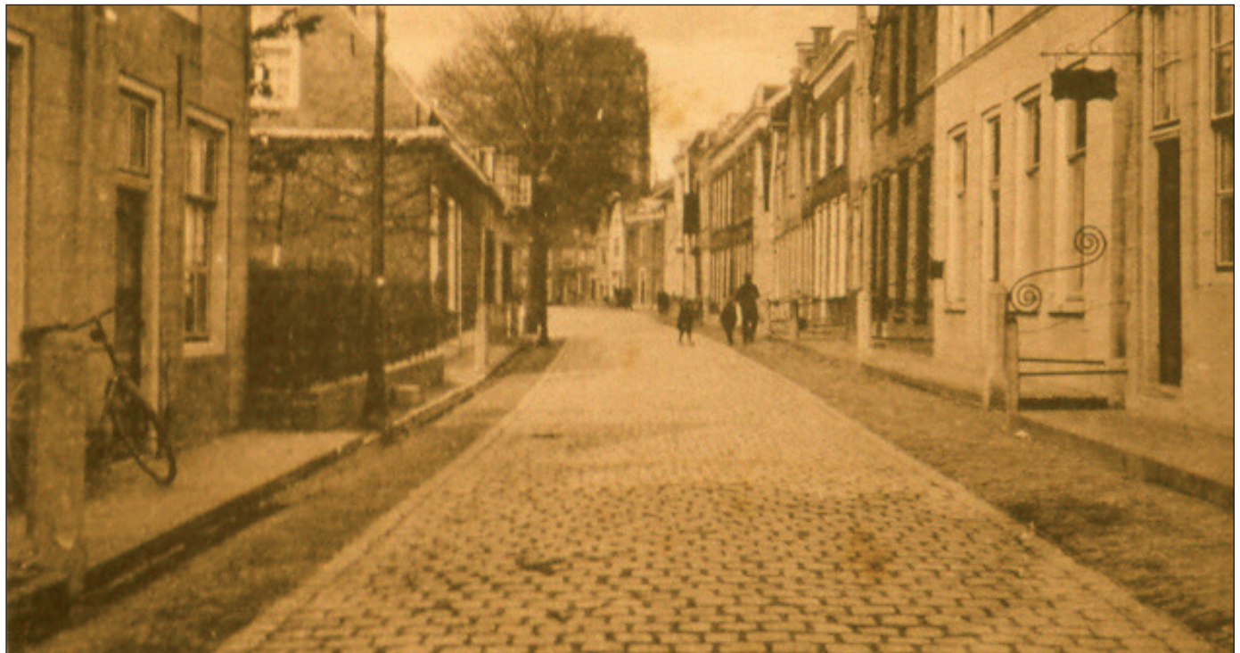
Noordzijde Haven richting de Markt: ook links een strook ijselsteentjes
