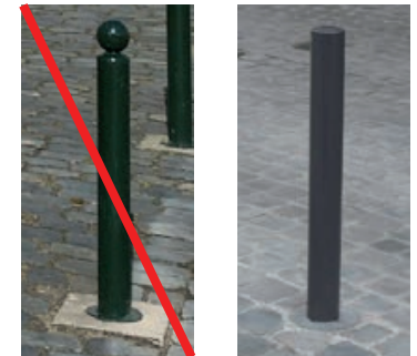
paaltjes met ronde betonnen voet in plaats van een vierkante
